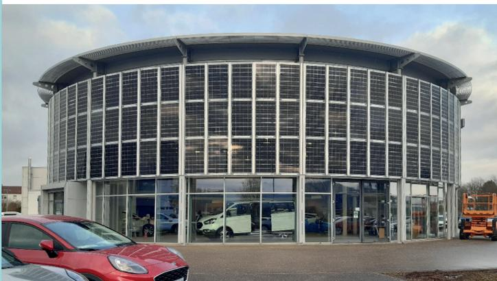
Das rahmenlose Photovoltaik-Glas hat eine Transparenz von etwa 28%. Dadurch wird eine angenehme Verschattung realisiert. Die Module bieten Spielraum mit Licht- und Sonnenschutz. Für die nötige Robustheit sorgen zwei Gläser mit 4 mm Stärke als Vorder- und Rückseite. Dank des verwendeten Sicherheitsglases sind die Module durch das DIBt sowohl zur Überkopfmontage als auch zur Vertikalverglasung zugelassen.
